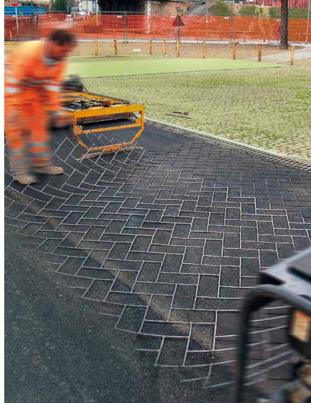
Fase di imprimitura con procedura di riscaldamento ad infrarossi dell'asfalto esistente Infrared Re-Heater SR60
