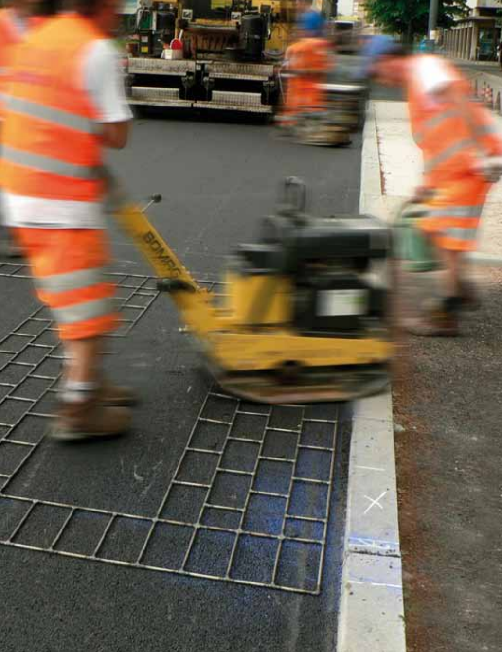
Cantiere di stampa e resinatura contestuale alla stesa del conglomerato
